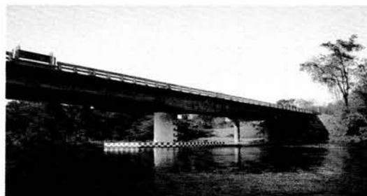
สะพานข้ามแม่น้ำแควใหญ่ บริเวณ หมู่ที่ ๘
